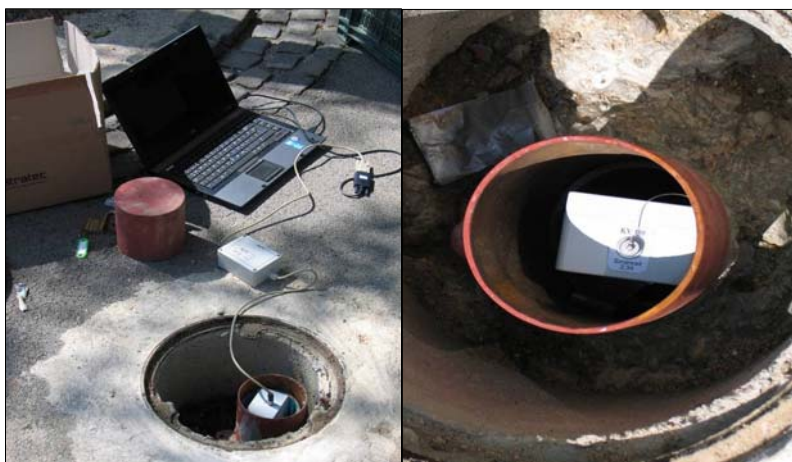
Slika 1: Vgradnja avtomatskih limnigrafov v nove piezometre.
