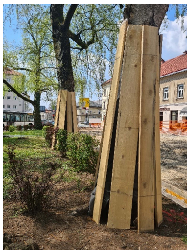
Slika 13: Zaščita debel na gradbiščih, ko zaščita rastnega prostora iz objektivnih razlogov ni mogoča.
