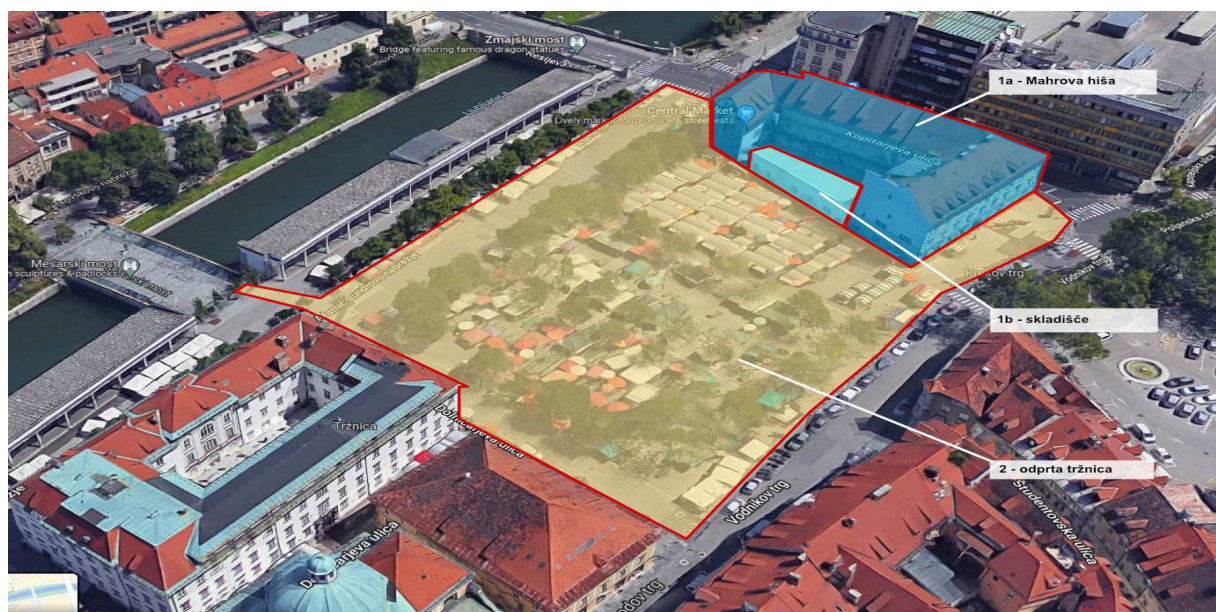
Slika 11: Objekti, na katerih se bodo izvajala rušitvena dela
