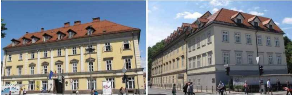
Slika 5: Mahrova hiša – pogled s S in J strani, obstoječe stanje
