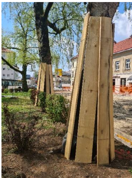
Slika 27: Zaščita debel na gradbiščih, ko zaščita rastnega prostora iz objektivnih razlogov ni mogoča (Tisa d.o.o., september 2023)
