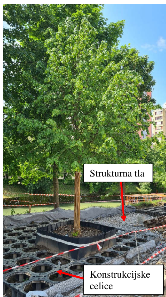
Slika 16: Sadilna jama je obdana s konstrukcijskimi celicami, ki so med seboj povezane s strukturnimi tlemi.
